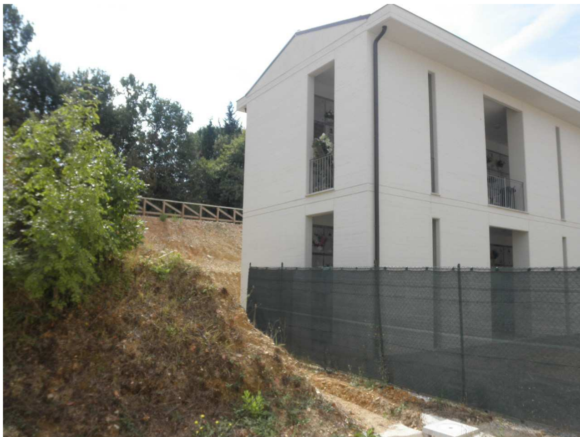
Foto n. 4 – Ultimo ampliamento anno 2012 (foto precedente ai lavori propedeutici di escavazione e rinterro)
