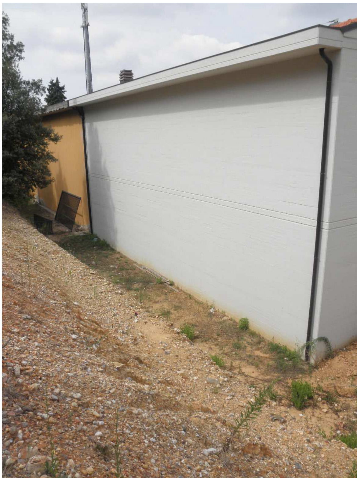
Foto n. 9 – Retro ultimo intervento anno 2012 (foto precedente ai lavori propedeutici di escavazione e rinterro)
