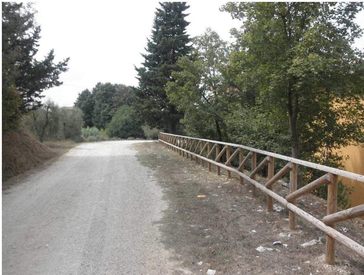
Foto n. 12 – Strada che conduce sul retro del Cimitero
