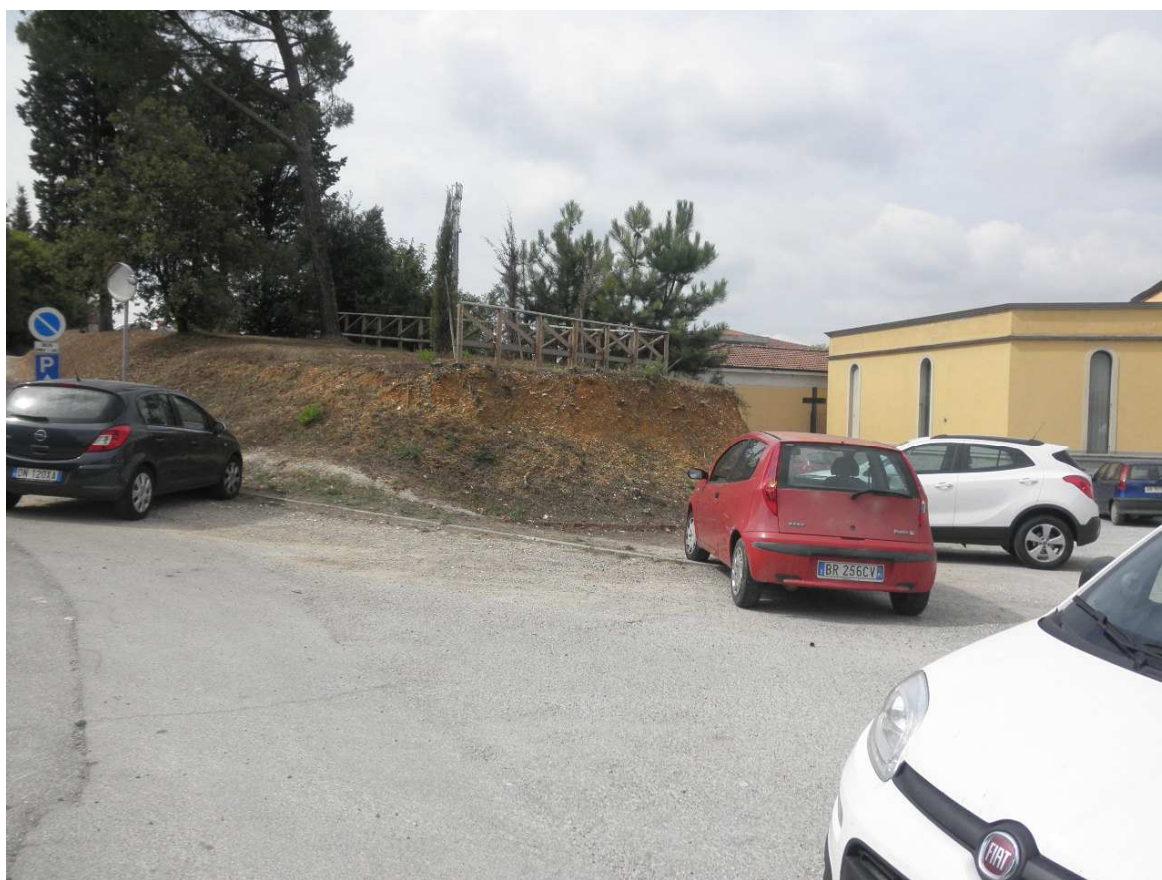
Foto n. 6 – Terrapieno che occupa parte dell'area di intervento (foto precedente ai lavori propedeutici di escavazione e rinterro)
