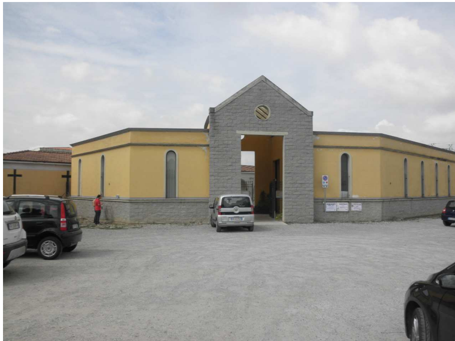
Foto n. 1 – Nuovo Ingresso al cimitero
