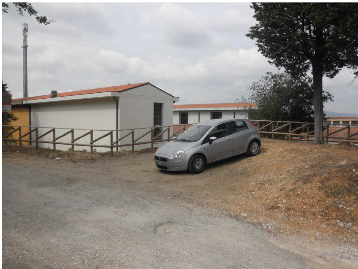
Foto n. 8 – Sommità del terrapieno in cui sorgerà il blocco con le cappelle (foto precedente ai lavori propedeutici di escavazione e rinterro)
